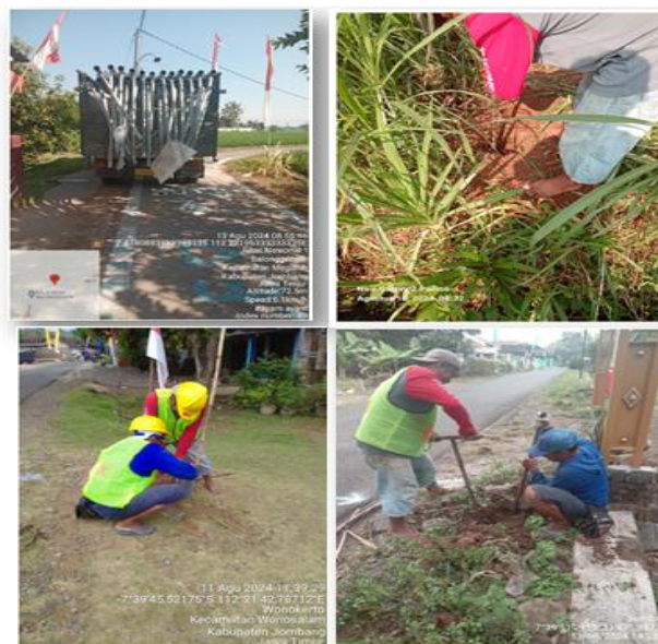
Gambar 2 Kegiatan Awal Pengangkutan Tiang PJU & Galian Pondasi Tiang PJU
